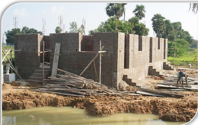
Het kerkje in Kunnavakkam in aanbouw
